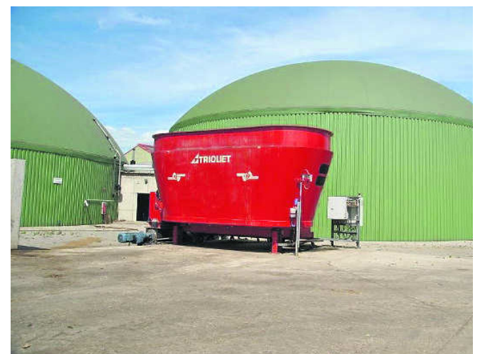
Resteverwertung: Die Biogasanlage auf dem Betriebsgelände Stemmen vergärt Gülle und Mist.
